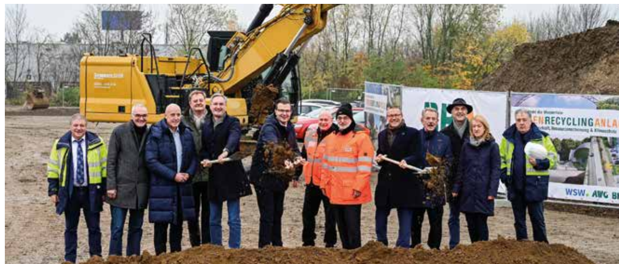
Spatenstich: (v.l.) Gerhard Daun (WSW Leiter Planung und Bau), Dietmar Bell (WSW-Aufsichtsratsvorsitzender), Markus Schlomski (WSW-Arbeitsdirektor), Peter Storch (WSW-Vorstandsmitglied), Markus Hilkenbach (WSW-Vorstandsvorsitzender), Sascha Grabowski (AWG-Geschäftsführer), Frank Schlenz (BRA-Geschäftsführer, AWG-Prokurist), Conrad Tschersich (Technischer Geschäftsführer der AWG), Uwe Schneidewind (Wuppertals Oberbürgermeister), Klaus Jürgen Reese (AWG-Aufsichtsratsvorsitzender) Georg Brodmann (Bezirksbürgermeister Vohwinkel), Dr. Ruth Anna Fischer-Bieniek (Bezirksbürgermeisterin Solingen Gräfrath) und Volker Linden (WSW Netzmanagement und -service).
